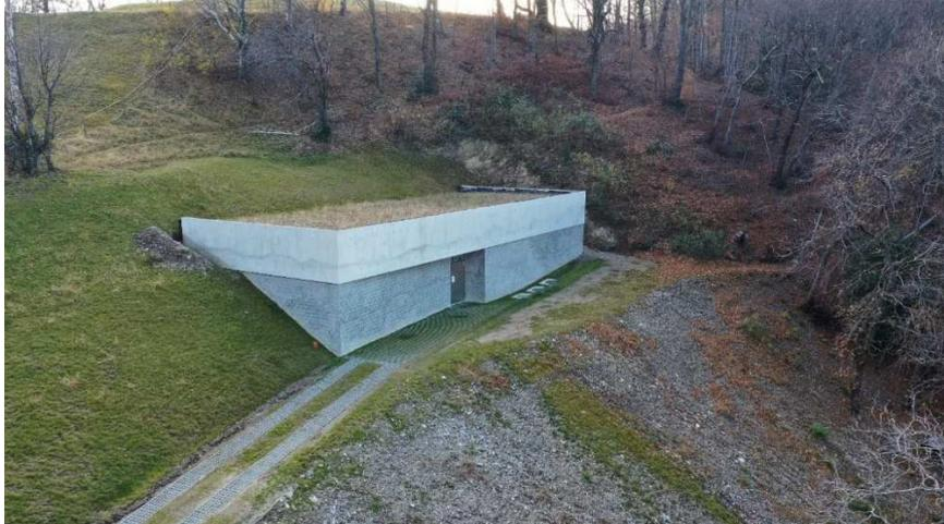
Ripresa aerea con drone del serbatoio di San Vitale, che permette la fornitura a tutta l'utenza dell'acqua potabile proveniente dalla stazione di potabilizzazione di Cà del Ferée. I due serbatoi della stazione permettono di mantenere agevolmente un consumo medio giornaliero di 910 metri cubi di acqua potabile o se preferite 910'000 litri, che corrispondono ad un consumo pro capite di 910 litri per abitante.
