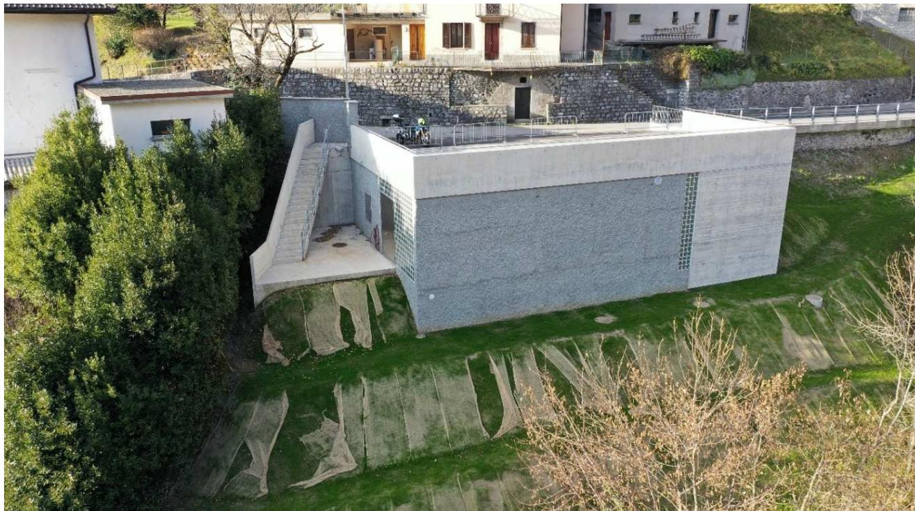
Ecco come si presenta vista dalla valle, la nuova stazione di potabilizzazione, di Cà del Ferée. Si nota il tetto a livello della strada mentre l'entrata al livello -1 si raggiunge utilizzando la scalinata.
