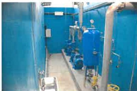
Qui ci troviamo al livello -2 della stazione, dove ci sono le pompe per il riempimento del serbatoio di San Vitale.
