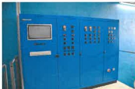
Tutta l'automazione della stazione di potabilizzazione e del serbatoio sono controllate dalla tecnica presente nei 4 armadi blu, mentre il monitor monitorizza tutti i componenti degli impianti.
