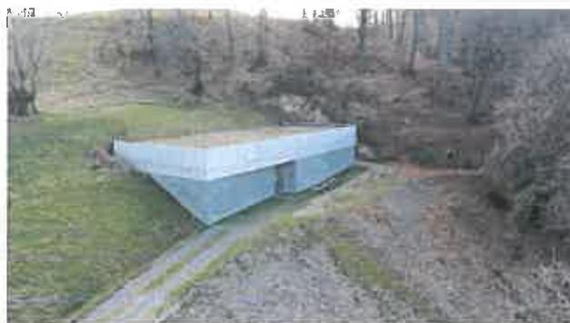
Ripresa aerea con drone del serbatoio di San Vitale, che permette la fornitura a tutta l'utenza dell'acqua potabile proveniente dalla stazione di potabilizzazione di Cà del Ferée.
