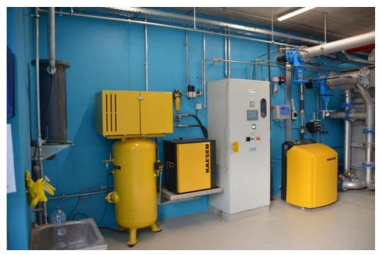
In questa foto si vedono l'armadio grigio che produce l'ozono per il secondo stadio di potabilizzazione per eliminare agenti biologici quale muffe, micro funghi, spore, lieviti e altri prodotti chimici presenti ancora dopo l'ultrafiltrazione. Le macchine in colore giallo è la sezione compressore che servono per il lavaggio periodico dei filtri che abbiamo visto nella foto precedente.
