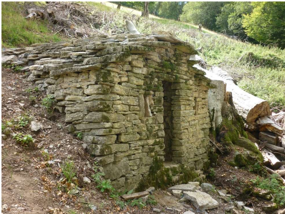
Il casello per la conservazione dei latticini ristrutturato.
